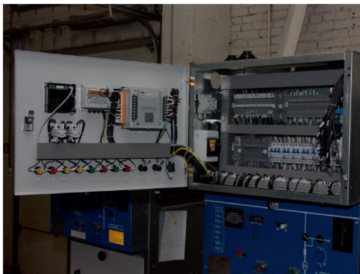
«Горизонт-35», Отсек вспомогательных цепей шириной 750 мм
