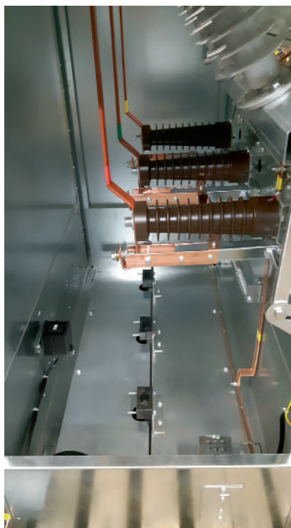
«Горизонт-35» Крепление для ввода кабеля
