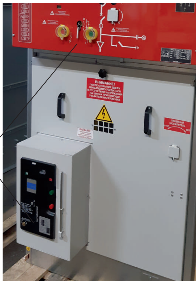
Установка навесного замка
