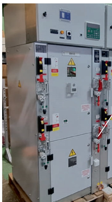
Электромагнитная блокировка Привода заземлителя и разъединителя
