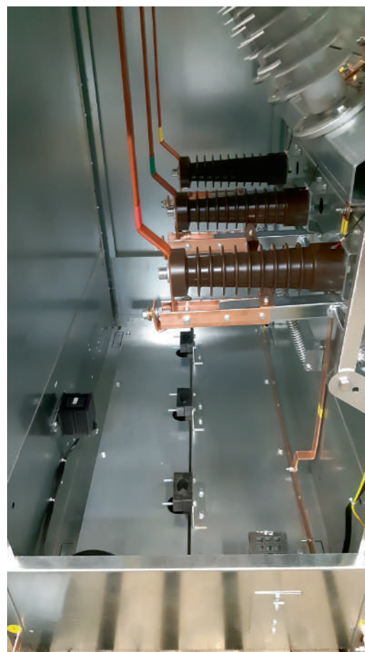
Нагревательный элемент
