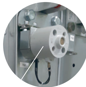
Электромагнитная блокировка ЗБ-1М
