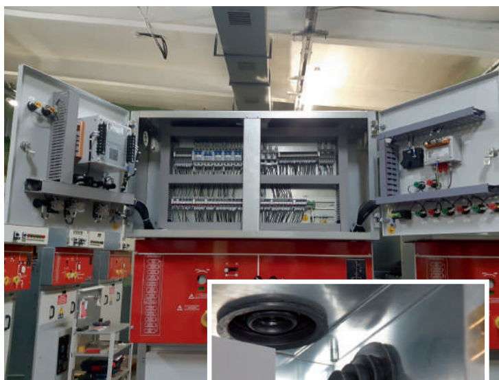
«Горизонт-35», Отсек вспомогательных цепей шириной 1000 мм
