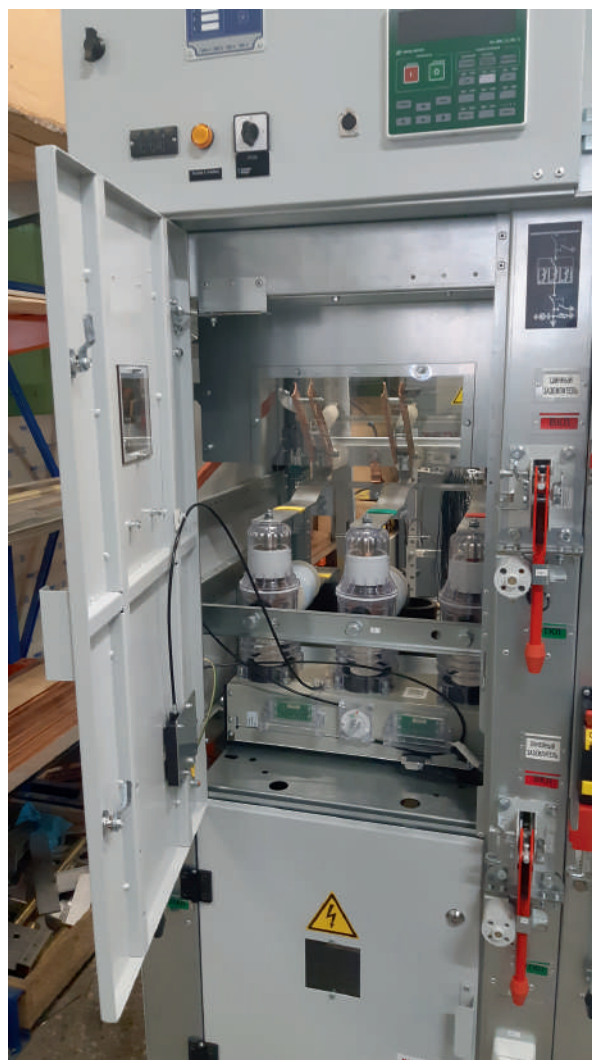
Высоковольтный отсек с выключателем ISM15
